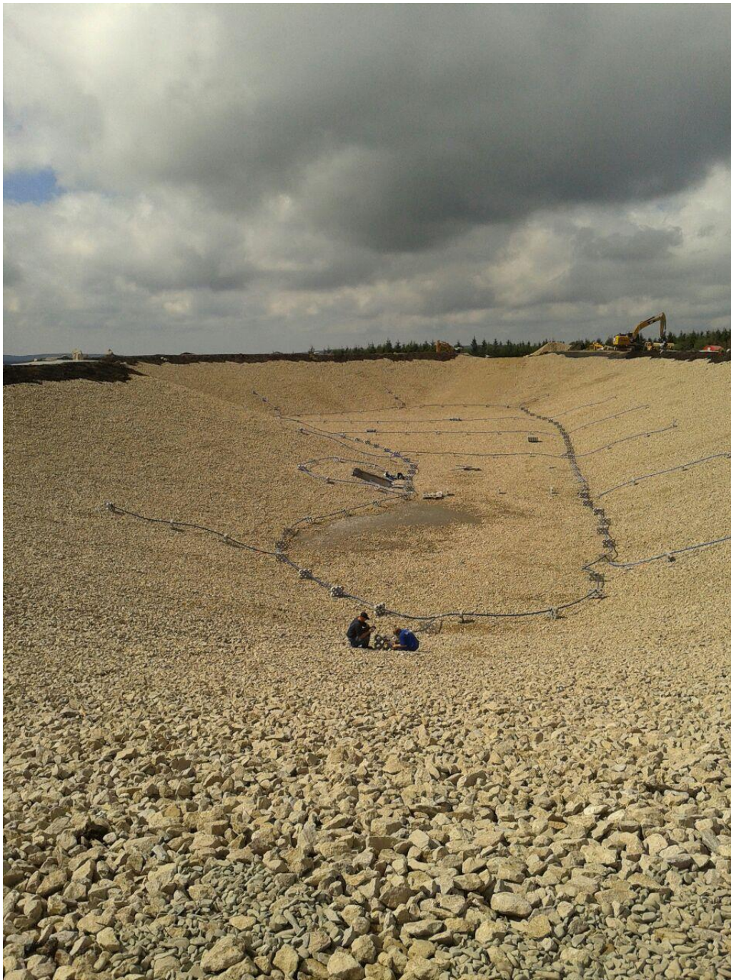
Abbildung 1 Anhand dieser Abbildung kann man die eingebaute Belüftungsanlage erkennen. Die Außenlastbehälter dürfen deshalb nur in der Mitte des Speichersees eingetaucht und möglichst oberflächennah befüllt werden (Foto: Wurmbergseilbahn GmbH).
